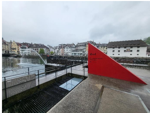
河道下的 Mühlenplatz 小水力電廠
