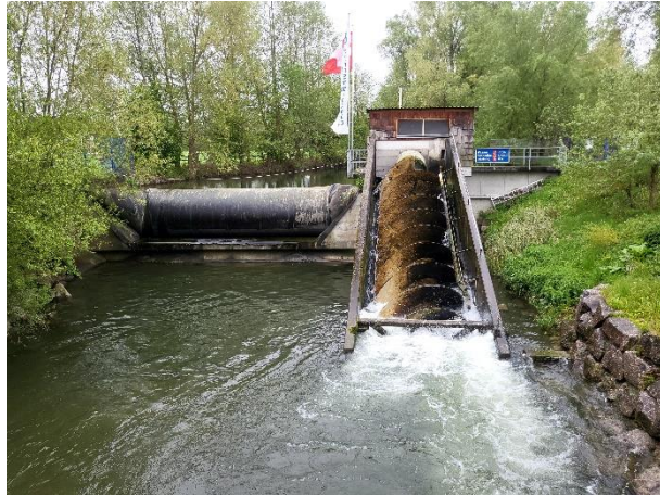
Hirschthal Pfiffner 小水力電廠及阿基米德螺桿
