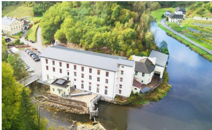
河畔的 WWS 公司、工廠與電廠
