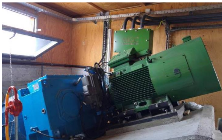
電廠內的發電機
